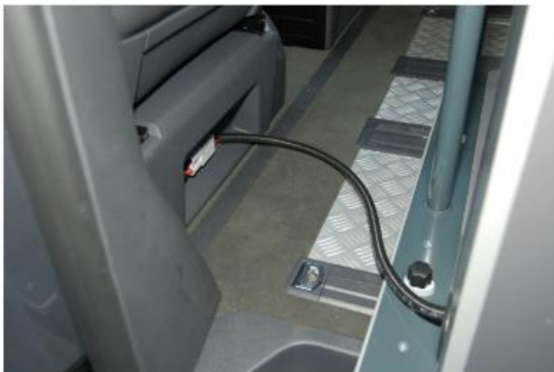
flexible 12 V Stromeinspeisung von der Fahrzeugbatterie zum Wechselrichter
